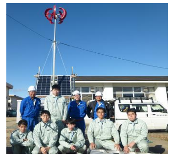
完成したハイブリッド発電システム
